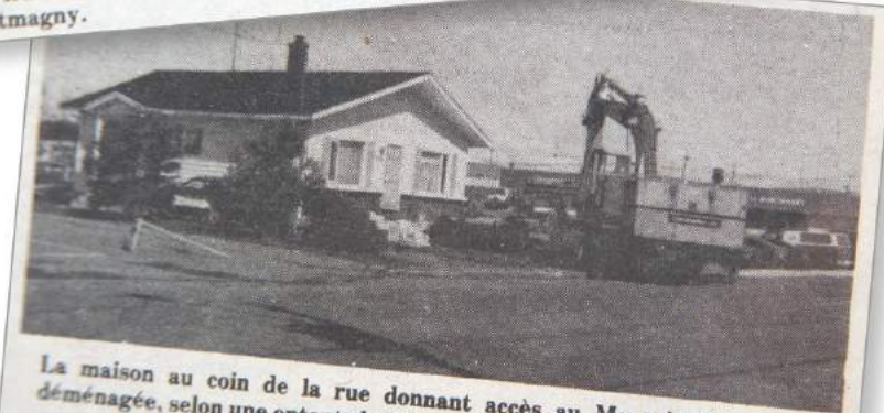
Les travaux d'agrandissement ont commencé au Magasin Coop de Montmagny.
